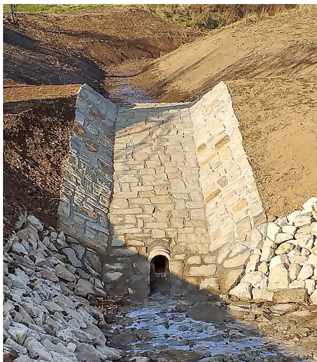
Byczeń - wybudowany zbiornik piętrzący wodę.
