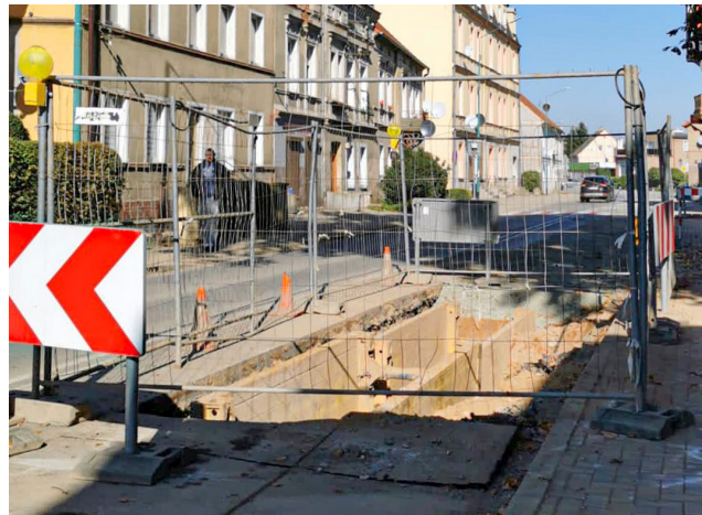
budowa sieci kanalizacyjnej w Kamieńcu Ząbk.
