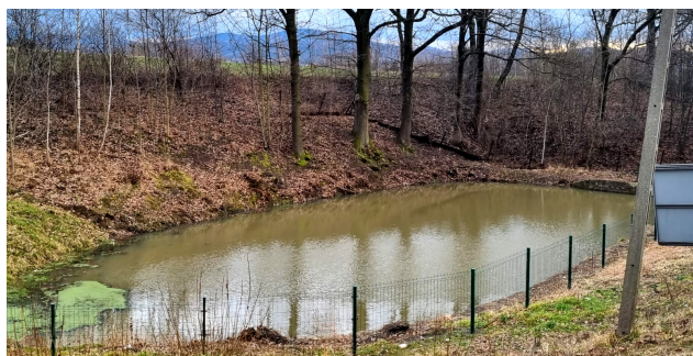
Sosnowa - modernizacja zbiornika.
