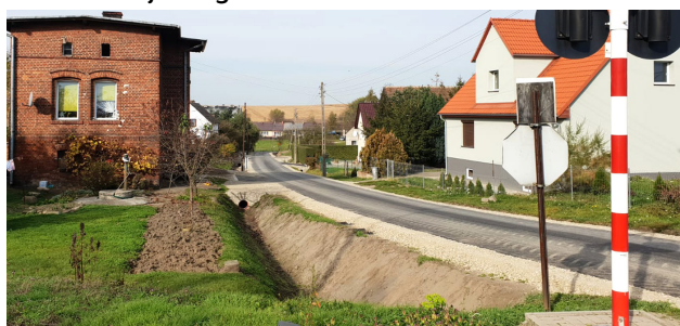
Starczów - pogłębienie rowów, wykonanie nowej drogi.
