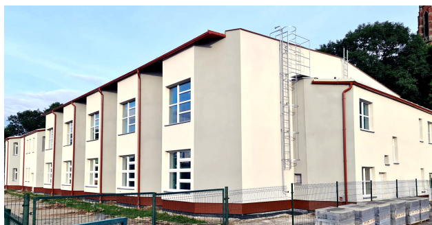
Kamieniec Ząbk. - termomodernizacja hali sportowej.
