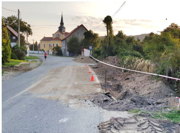
budowa sieci wodociągowej w Ożarach.
