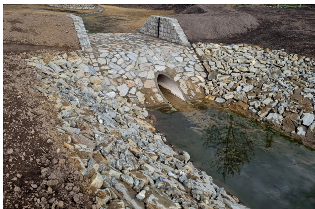
Starczów - wybudowany zbiornik retencyjny.
