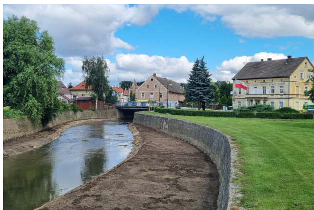
Kamieniec Ząbk. - pogłębienie rzeki Budzówki.
