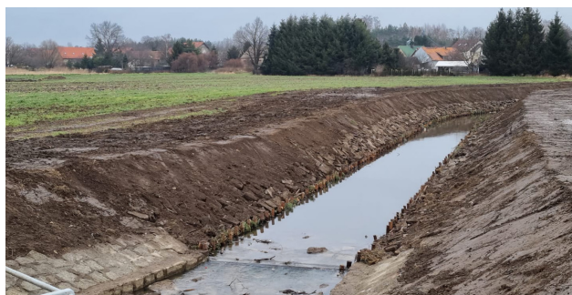
Kamieniec Ząbk. - pogłębienie cieku wodnego.
