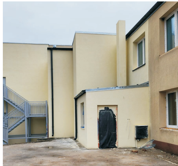
Trwa modernizacja budynku gminnego w Doboszowicach
