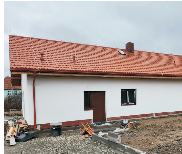
Budowa nowej świetlicy wiejskiej w Sołectwie Ożary
