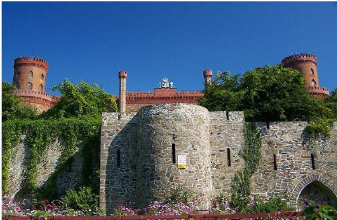
Fot. 1: Pałac w Kamieńcu – widok od południowego zachodu 13
