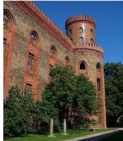
Fot. 2: Pałac w Kamieńcu – widok na jedną z wież 14
