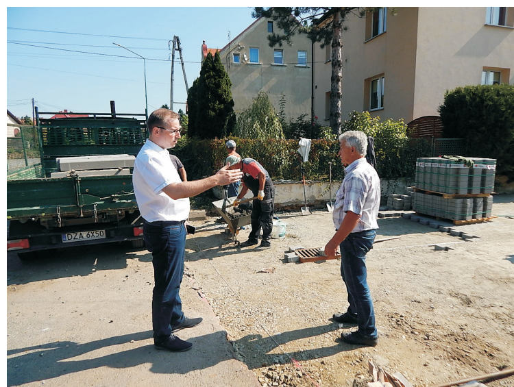
Dobiega końca remont drogi dojazdowej do nieruchomości przy ulicy Skoroleckiej
